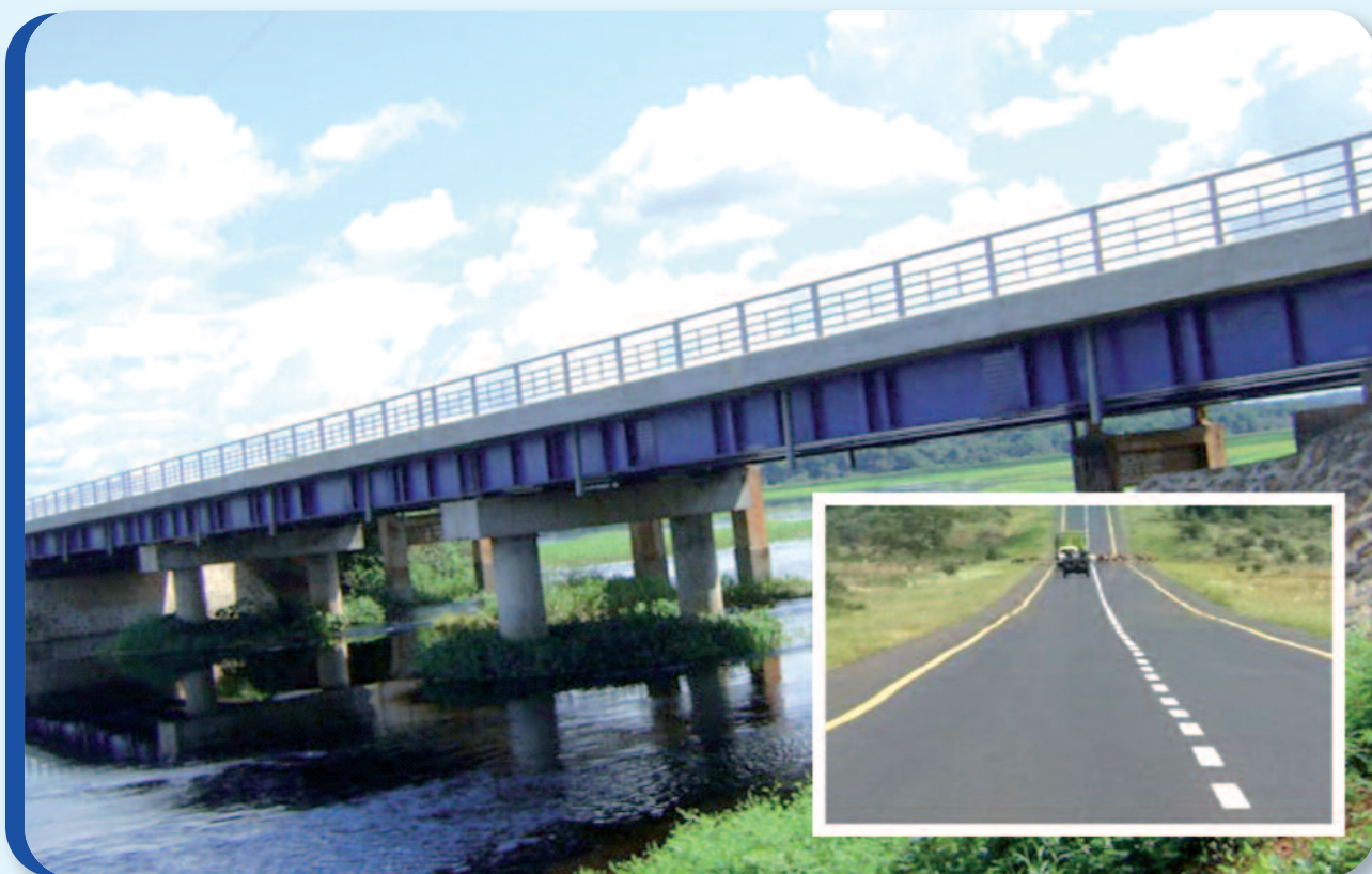
Pont sur le fleuve Nyong à Ayos, route Ayos - Bonis.
