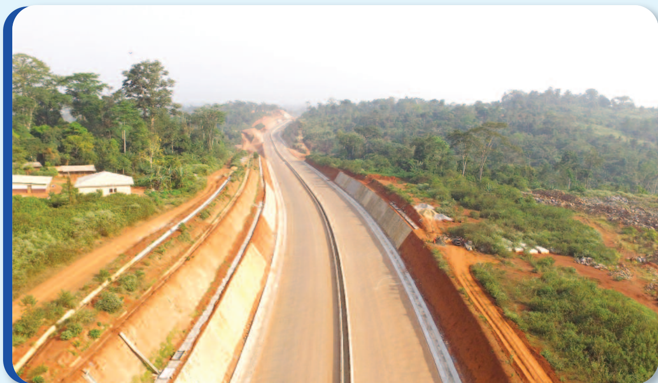
Section rase campagne de l'autoroute Yaoundé-Nsimalen.
