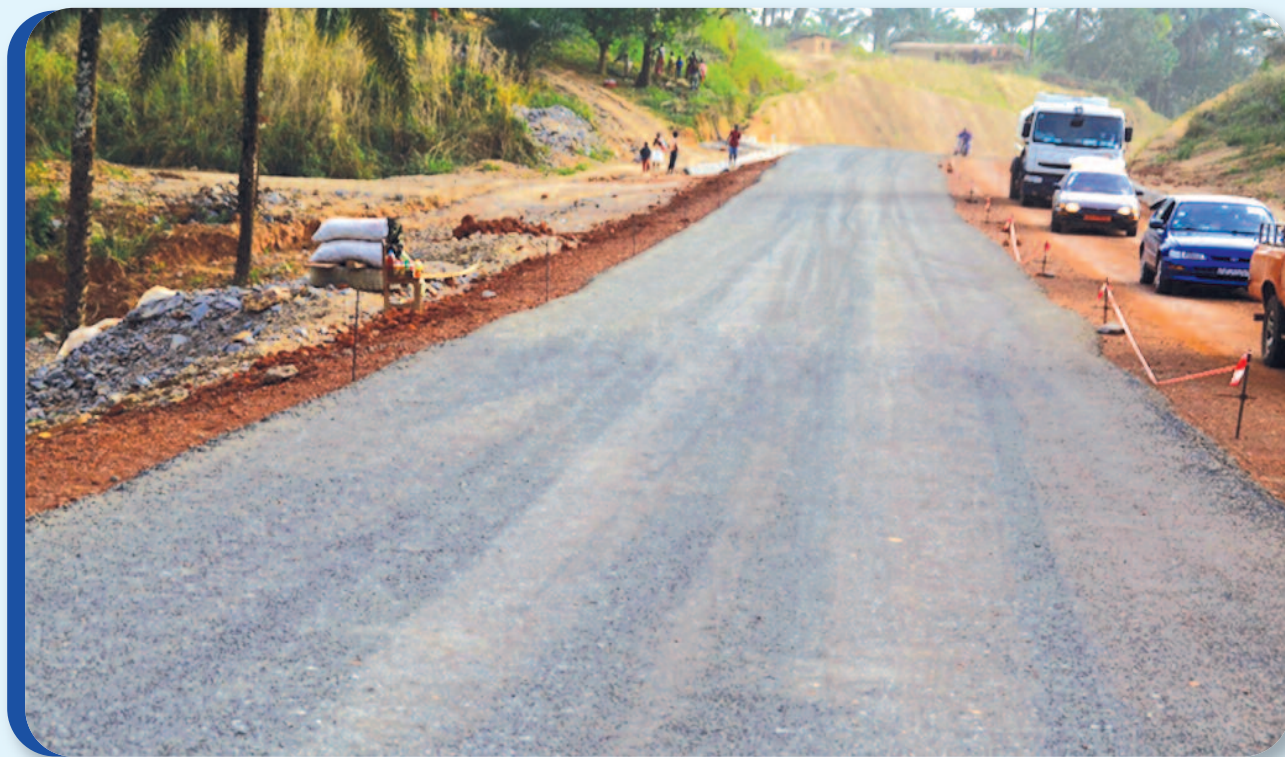
Dans la région de l'Ouest, le bitumage de la route Galim-Bamendjing-Foumbot-Bangangté est achevé.
